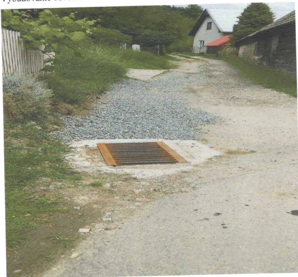
Vybudovanie odvodňovacieho kanála so šachtou:
